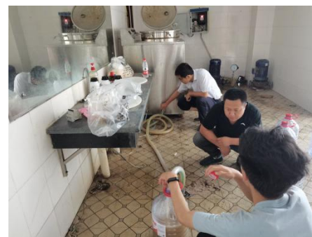
图 25 正在安装发酵罐（白果坪）
