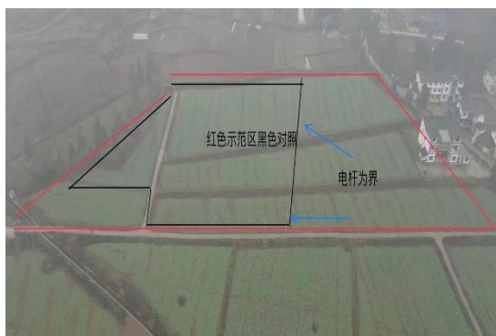
图 2-6 正安市坪示范区
