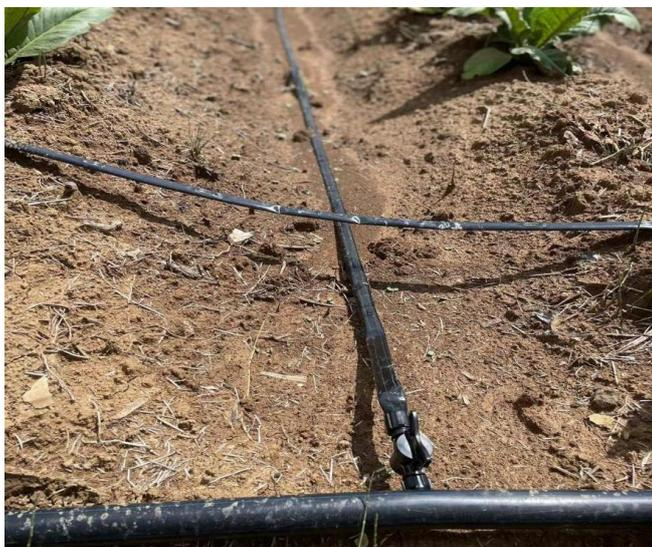
图 6 实验小区滴灌系统安装
