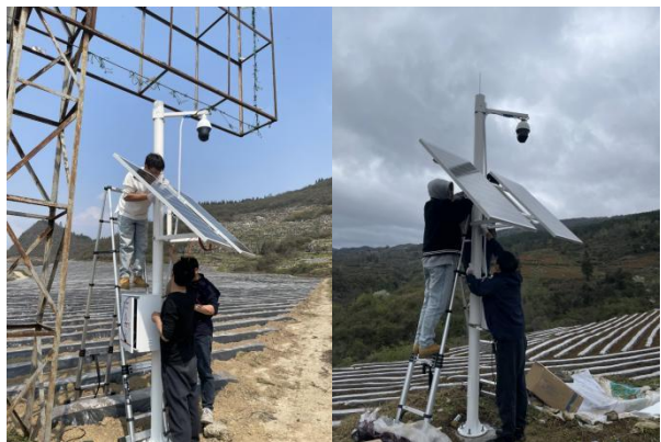
图 3、4 项目组成员在示范区安装植保信息采集设备
