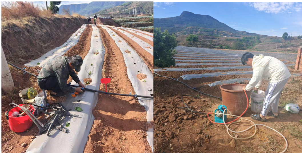
图 11 滴灌管道铺设
